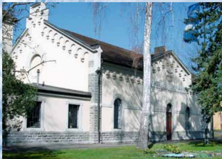
康斯坦茨自来水厂对 Beckhoff 基于 PC 的控制技术进行了升级。这带来了更好的操作舒适性和更高的供水安全性。
